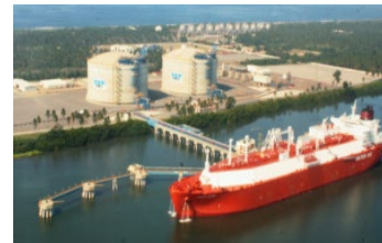
LNG Terminal (Manzanillo)
