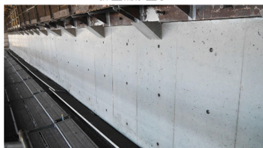
大林組 ほか 擁壁補修工事
