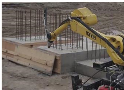
RENCA 可搬式3Dプリンターによる現場施工
