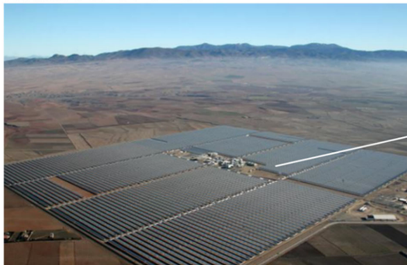
太陽熱発電プラント全景
