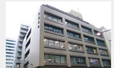
三井物産都市開発が保有する物産ビル外観
