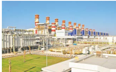
ラスラファンC造水プラント
