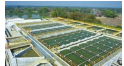
TTW浄水場全景
