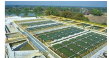
TTW浄水場全景
