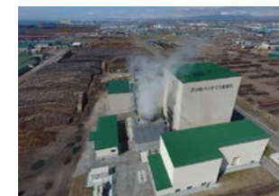
苫小牧バイオマス発電所
