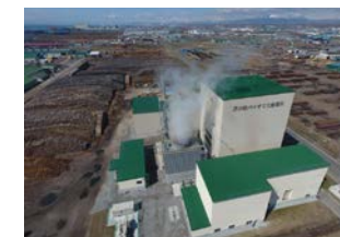
苫小牧バイオマス発電所
