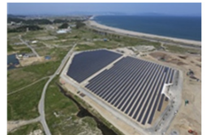
東松島市に建設した大規模太陽光発電所
