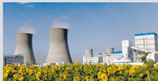
事業所内の発電所
