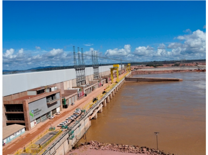
ジラウ水力発電所
