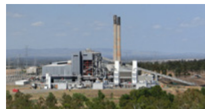
豪州クィーンズランド州カライドA石炭火力発電所4号機の酸素燃焼ボイラーとその付帯設備
