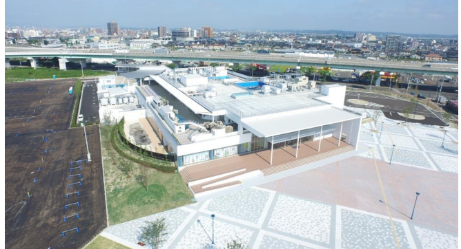
津波避難施設としても活用
