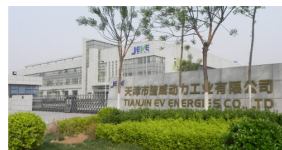
天津市捷威動力工業有限公司工場建屋
