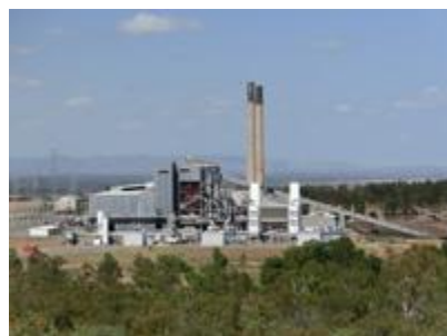
豪州クィーンズランド州カライドA石炭火力発電所4号機の酸素燃焼ボイラーとその付帯設備
