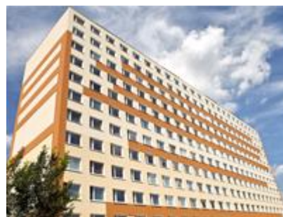
補助金制度を利用した外壁・窓枠の断熱改修
