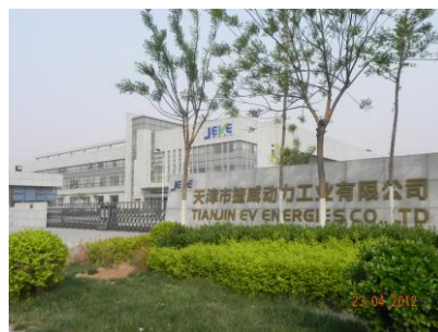
天津市捷威動力工業有限公司工場建屋
