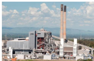
豪州クィーンズランド州カライドA石炭火力発電所4号機の酸素燃焼ボイラーとその付帯設備
