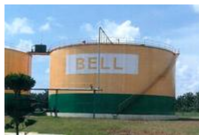
浄化槽で排水を処理し、メタンガスを回収
