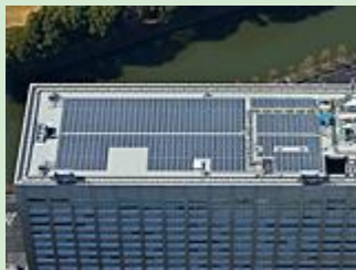
本社屋上に設置された太陽光発電パネル
