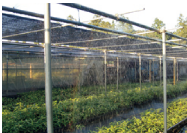
自動灌水装置のお陰で人力による灌水作業は軽減された
