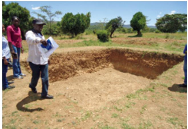
掘削用の小規模ため池。この後スロープをつけ、土砂の崩壊を防ぐ予定
