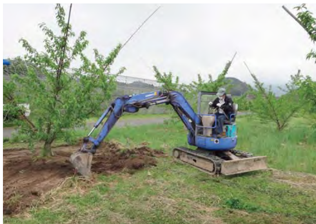
除染の効果を確かめるため果樹園の表土を剥離している様子
