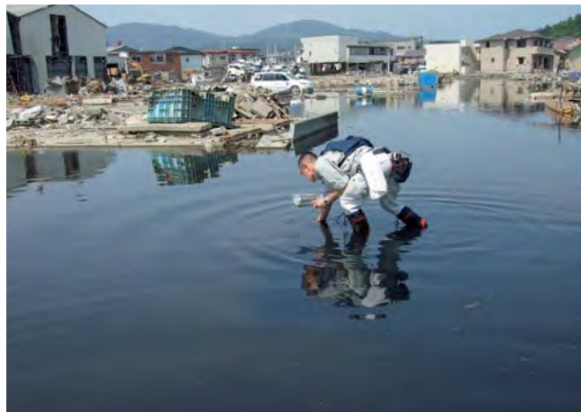
気仙沼市幸町におけるヘドロ採取の様子。地盤沈下により常時冠水し、そこにヘドロが残留・堆積していた。
