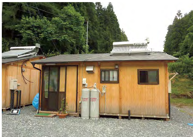
岩手県住田町の木造仮設住宅に太陽熱温水器を設置
