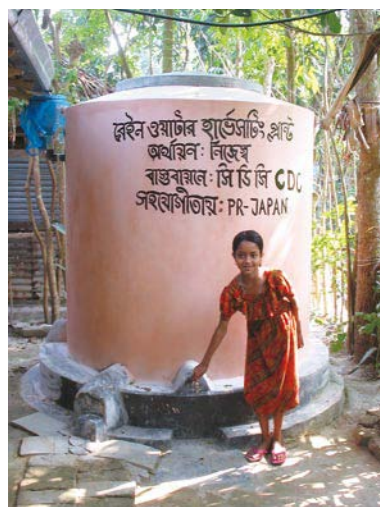
バングラデシュに設置した雨水タンク
