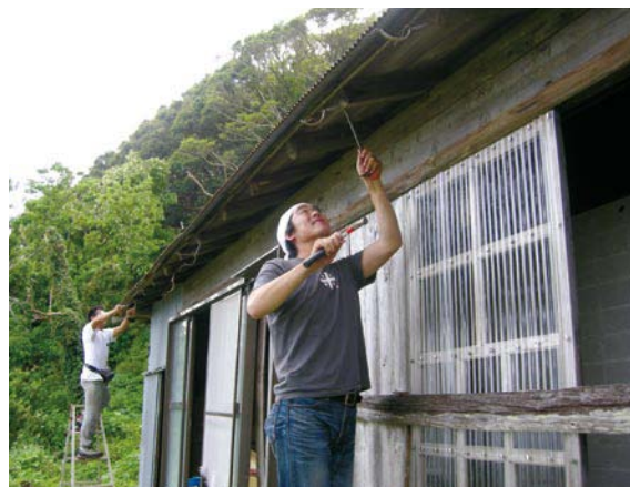
御蔵島での環境教育の拠点となる古民家の改修風景
