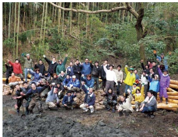
八尾市郡川下流部での保護池の浚渫と土手改修工事
