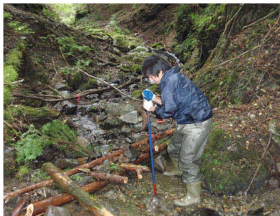
間伐材の利用による淵の造成
