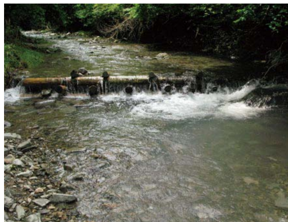
奈良県十津川水系における間伐材の利用による淵の造成
