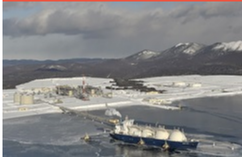
サハリンⅡプロジェクト（ロシア） ©Sakhalin Energy Investment Company Ltd.
