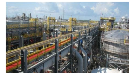
電解工場の建設現場
