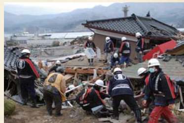
瓦礫撤去作業にあたる消防団員
