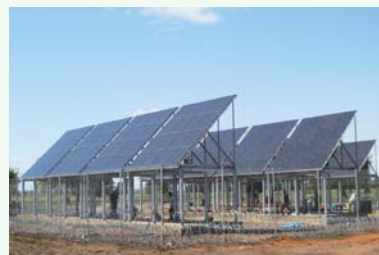
建設中の太陽光発電設備
