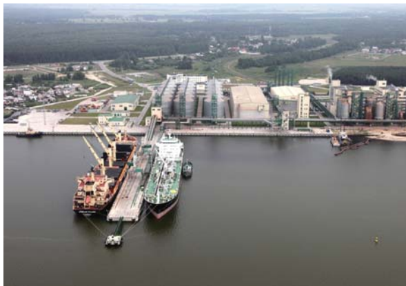
サドル社の工場および穀物輸出入用港湾設備
