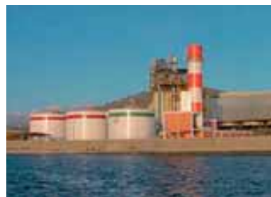
買収対象の一つ、Saltilloガス複合火力発電所
