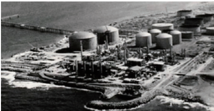
アブダビ・ダス島LNG開発(写真は1970年代のもの)
