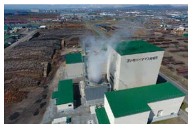
苫小牧バイオマス発電
