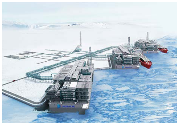
コンクリート製の洋上着床型構造物の上に設置された液化設備
