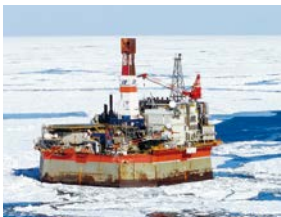
②サハリンⅡプロジェクト(ロシア) ©Sakhalin Energy
