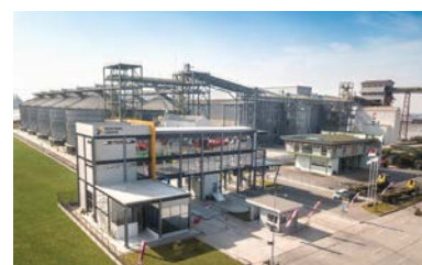
FKSFA社の穀物輸入設備
