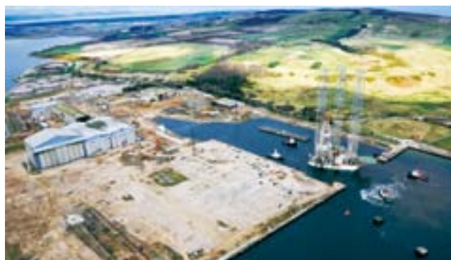
欧州最大級のドライドックであるGlobal Energy社のNiggヤード（イギリス）
