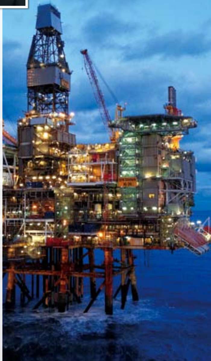
Britanniaガス・コンデンセート田洋上プラットフォーム（北海） ©Britannia Operator Limited
