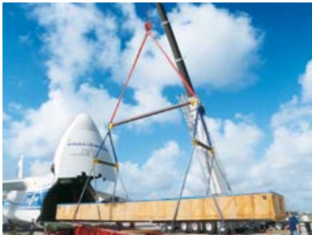
AN-124機からの火力発電機の荷下ろし作業（アメリカ）
