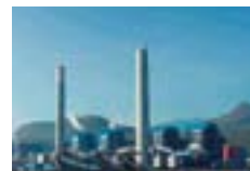
パイトン石炭火力発電所 (インドネシア)
