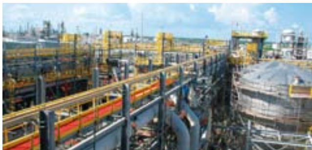
電解工場の建設現場（アメリカ）
