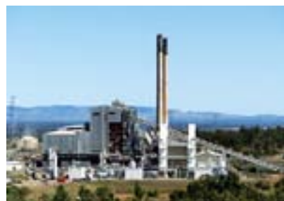
Callide A 発電所全景（オーストラリア）
