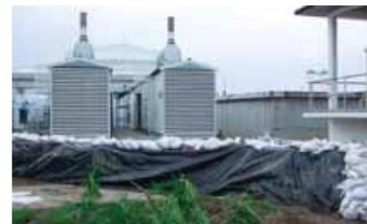
施設への浸水を防ぐために築いた堤防
