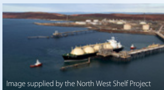
NWS LNGプロジェクト
