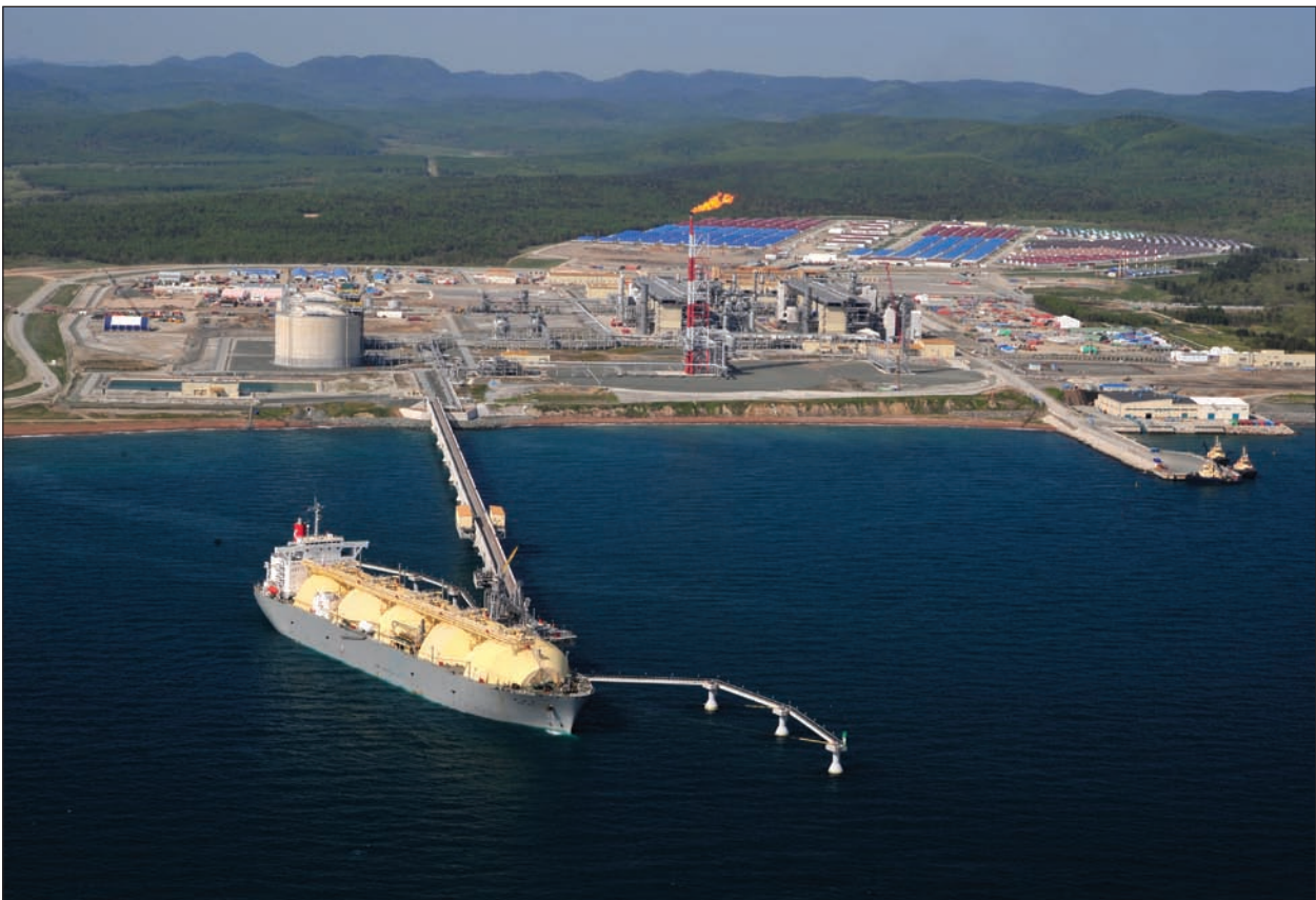
Завод СПГ проекта «Сахалин-2»
