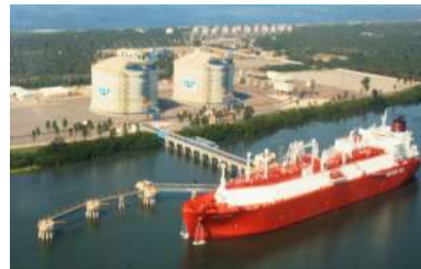
LNG Terminal (Manzanillo)
