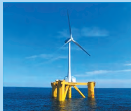
図表 13 経済産業省による浮体式 洋上風力発電の実証研究事業 (福島県福島沖 2MW 風車)
