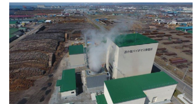
苫小牧バイオマス発電
