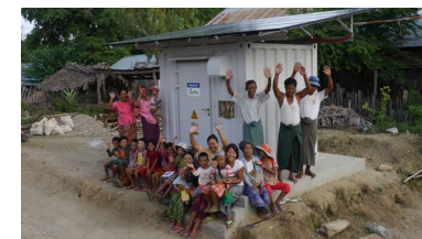
ソーラー電源設備と住民たち
