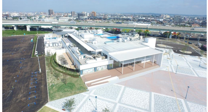
津波避難施設としても活用
