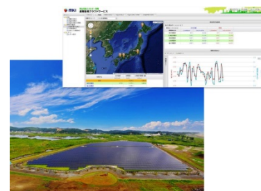
太陽光発電所設備と遠隔監視画面イメージ
