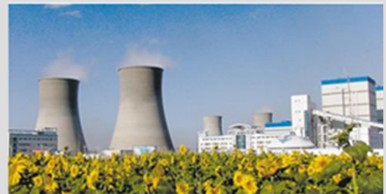
事業所内の発電所
