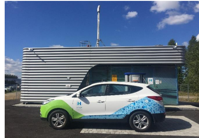
燃料電池自動車用水素ステーション(炭素繊維製タンクを使用)
