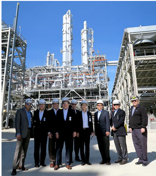
現場①：米国メタノール製造工場
