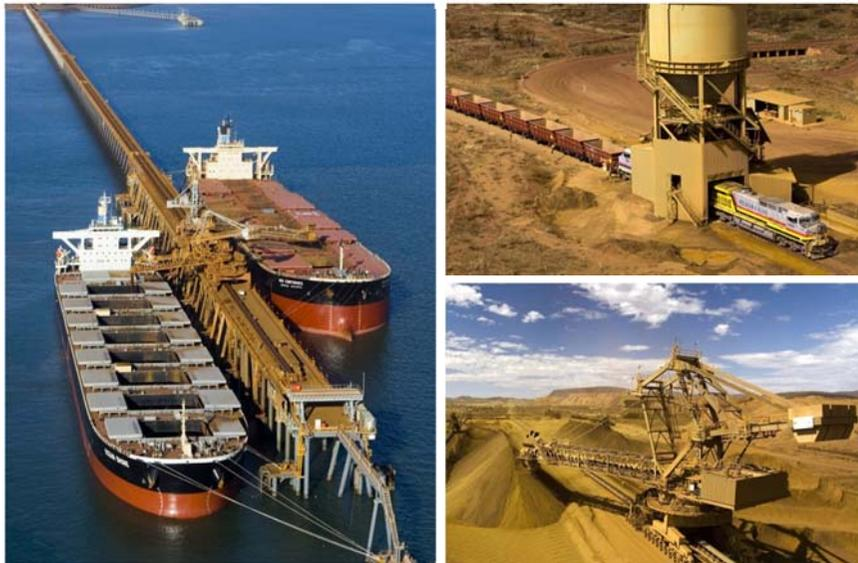
豪州ローブリバーJ/Vの操業。採掘された鉄鉱石は貯蔵場(写真右下)を経て貨車に積込まれ(写真右上)、約400km先の専用港(写真左)まで輸送される。
