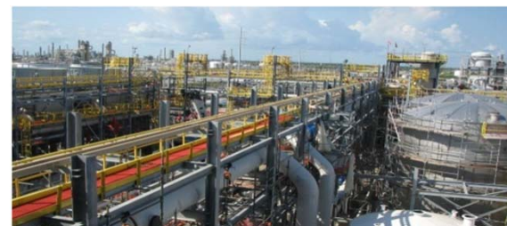
電解工場の建設現場
