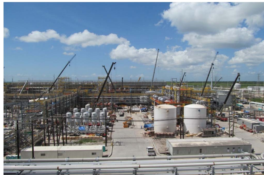
電解工場の建設現場
