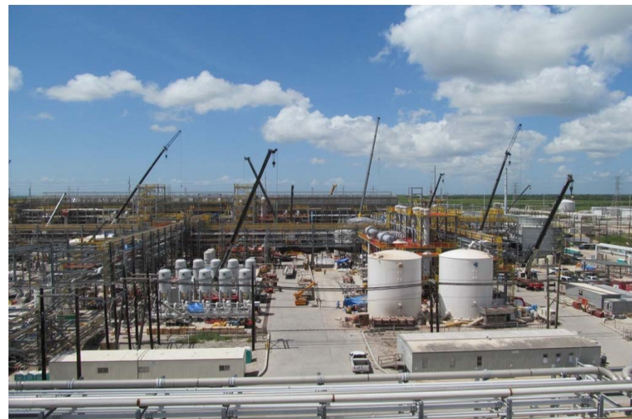
電解工場の建設現場
