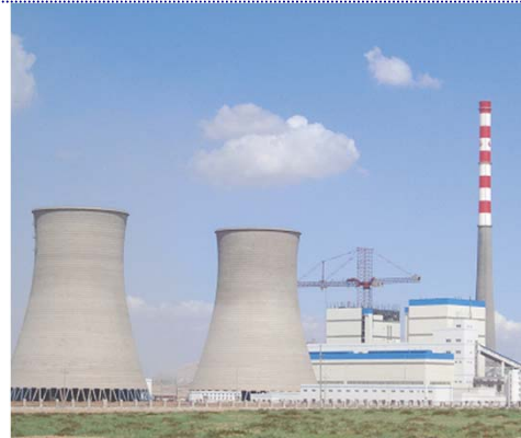
オトルス電力冶金の火力発電所
