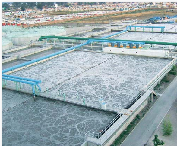
エル・アオガード下水処理場
