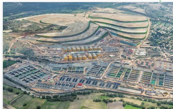
建設中のアトトニルコ下水処理場
