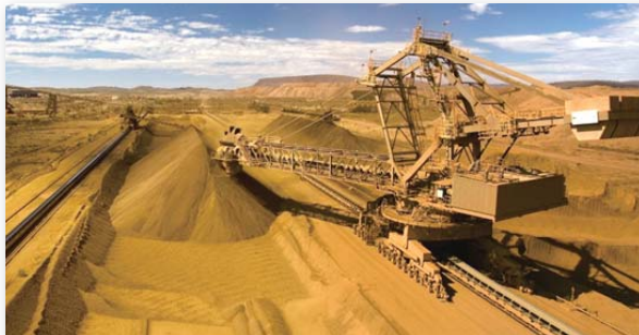
ウエスト・アンジェラス鉄鉱山の鉄鉱石ストック・ヤード（貯蔵場）
