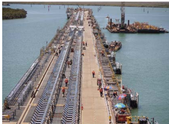
拡張工事中のポートヘッドランド港
