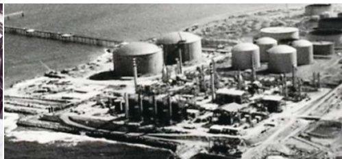
②アブダビ・ダス島LNG開発(UAE)
