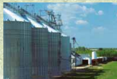
カントリーエレベーター
