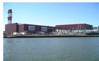
IPP事業（米 アストリア I ガス火力発電所）
