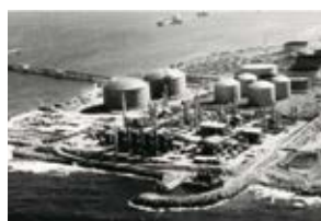
The Abu Dhabi LNG project (UAE)
